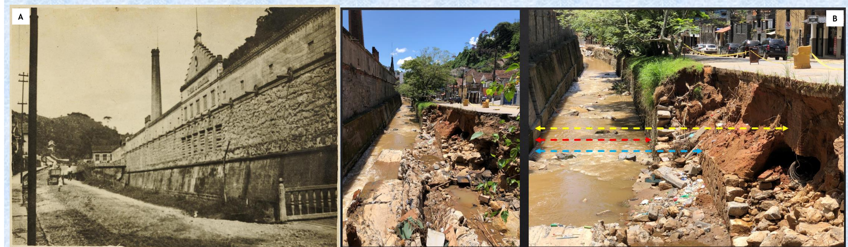
Fig. 2 - (A) Fábrica de Tecidos São Pedro de Alcântara e a rua contígua. Vista para montante. (B) O rio Quitandinha, visto para a jusante (fábrica à esquerda), mostrando o desbarrancamento de parte da margem direita, sobre a qual está a rua Washington Luis. A erosão provocada pelas fortes chuvas de fevereiro de 2022 expôs antigos elementos construtivos de contenção. Compare a largura atual do rio, marcada pela linha vermelha, com as linhas azul e amarela. Imagem de Manoel do Couto Fernandes (2022).
